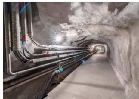
GALERIE L'impressionnant couloir de la galerie Rossignol du fort de Dailly, que l'on pourra visiter une dernière fois ce week-end.
